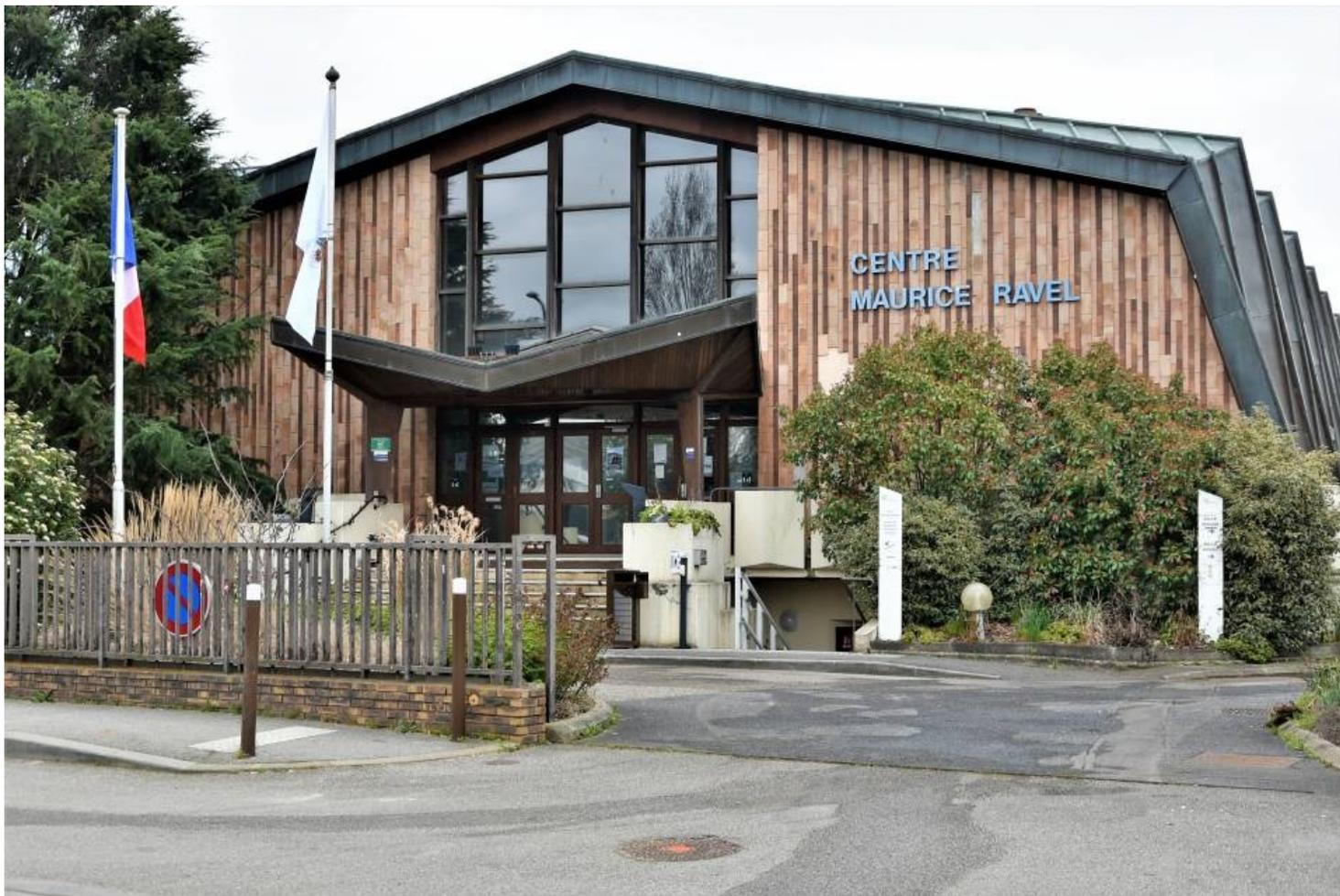
La façade du bâtiment étant abîmée, il était nécessaire d'enlever l'intégralité des briquettes. Une vature isolante avec un aspect brique dans des teintes chaudes et naturelles va être fixée. Les panneaux isolants de 60mm d'épaisseur sont conçus pour limiter les ponts thermiques. Un choix à la fois écologique et esthétique. La toiture, quant à elle, va être remise en état.
