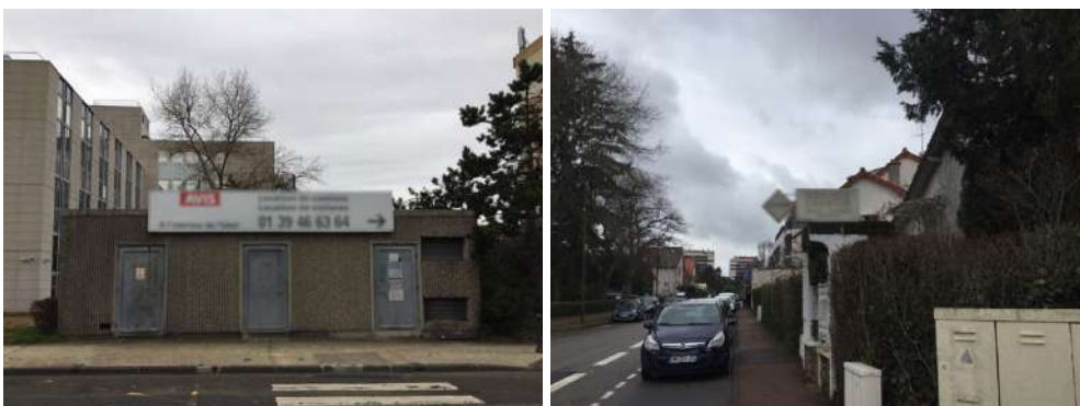
Enseignes dépassant la limite supérieure du mur ou de l'égout du toit
