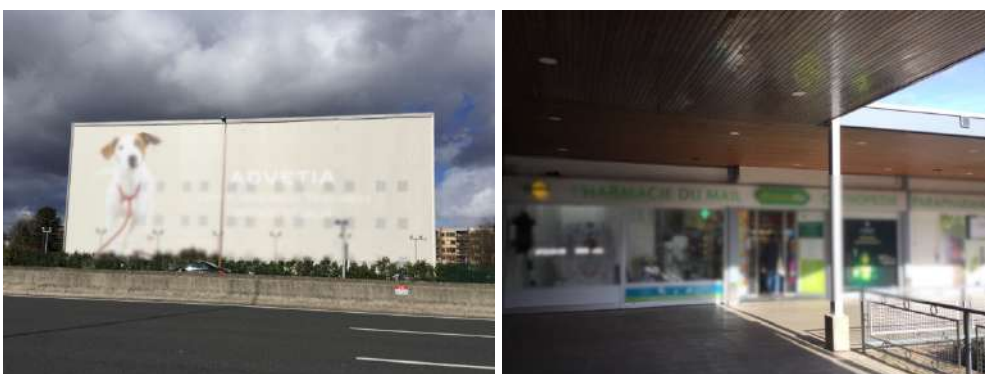
Exemples de façades saturées d'enseignes
