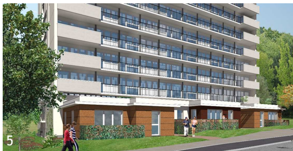
92, place Louvois – façade est vers Exelmans
