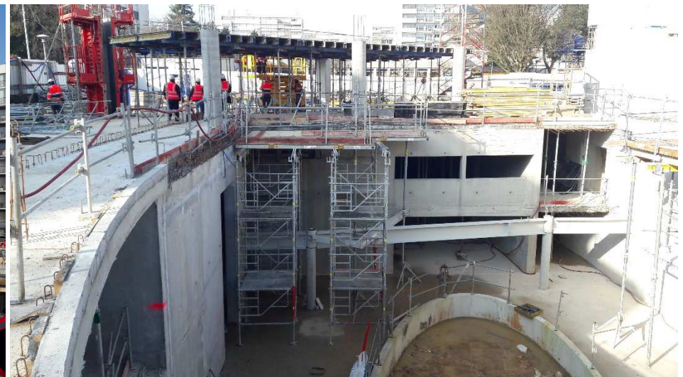
Atrium de la rampe
