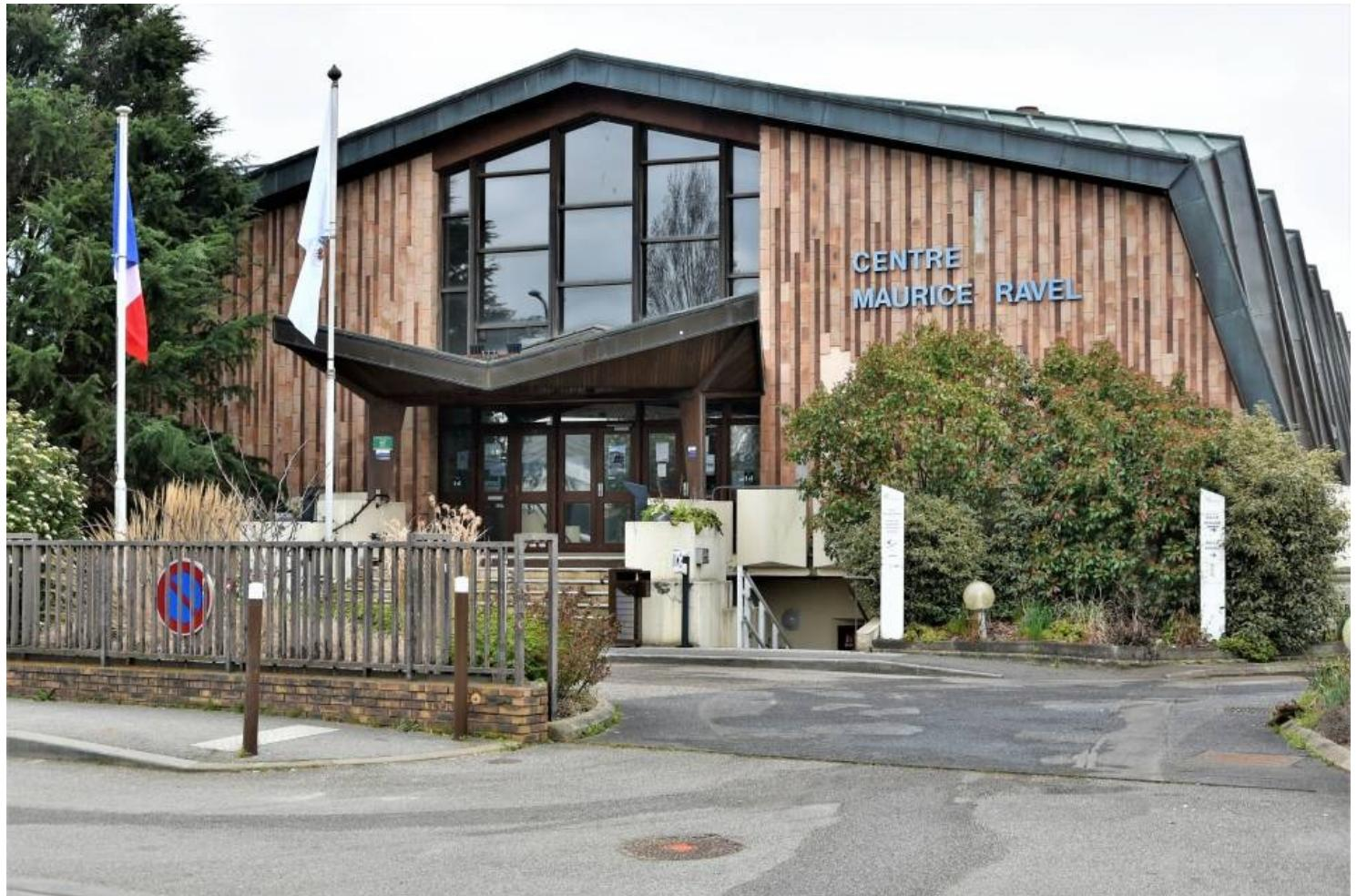
La façade du bâtiment étant abimée, il était nécessaire d'enlever l'intégralité des briquettes. Une végétation isolante avec un aspect brique dans des teintes chaudes et naturelles va être fixée. Les panneaux isolants de 60mm d'épaisseur sont conçus pour limiter les ponts thermiques. Un choix à la fois écologique et esthétique. La toiture, quant à elle, va être remise en état.
