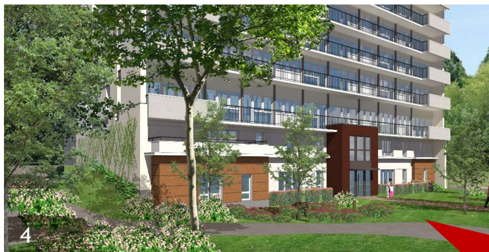
( T4) 38, place Louvois – façade est vers Exelmans
