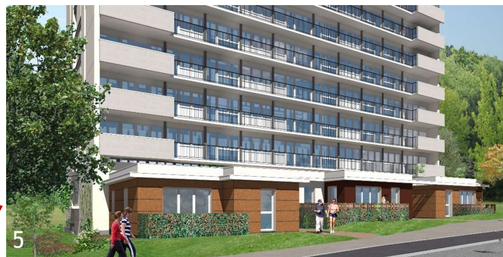
( T5) 92, place Louvois – façade est vers Exelmans
