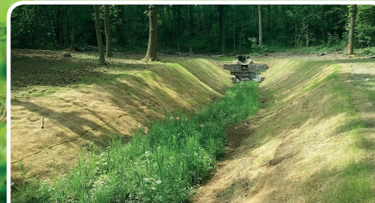
Les berges de la noue ont été engazonnées et le fond, tapissé de fibre de coco, accueille des espèces végétales dépolluantes.
