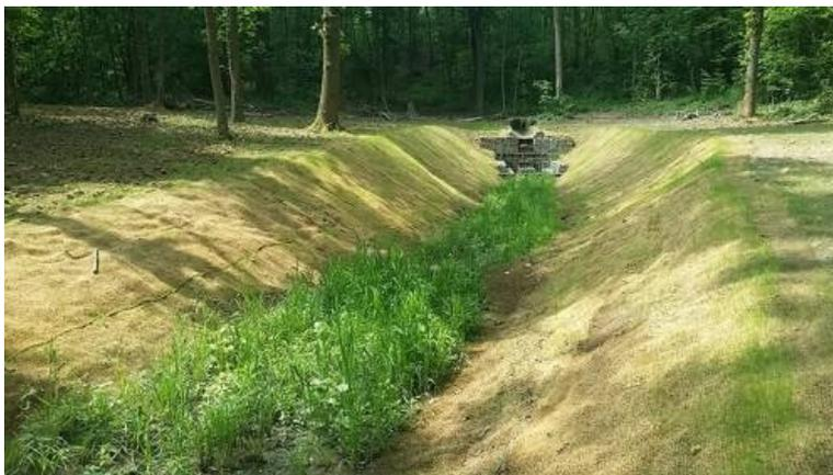
Vieillissante, la noue s'est progressivement déformée; incapable d'accueillir le volume d'eaux pluviales, et allant jusqu'à former un ravin naturel de 4 mètres de profondeur !
